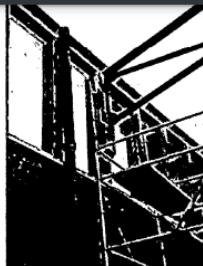
Ilustración 2: Cara interna fachadas con ventanería, ménsulas a demoler y cerchas a sostener.
